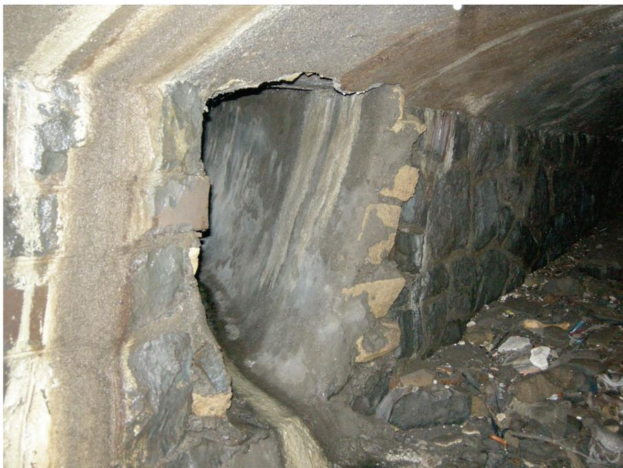
**Foto 4.** *Immissione in sinistra idraulica di reflu fecale proveniente da Corso Italia.*
