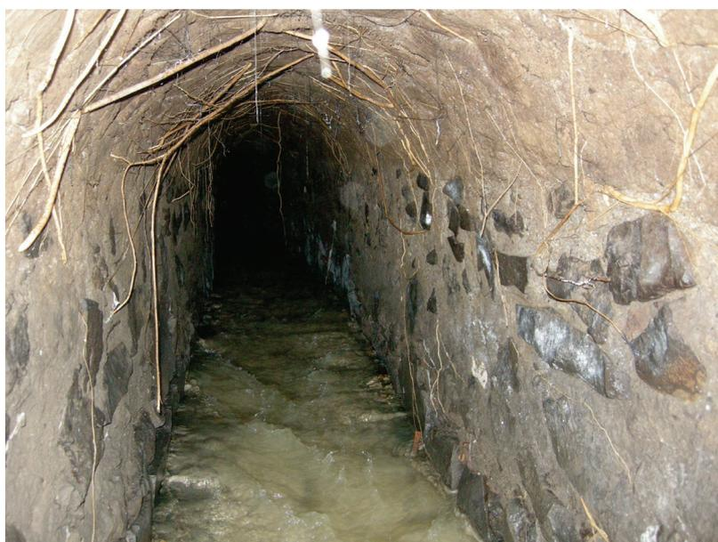
*Foto 9. Scatolare esistente da sostituire*
